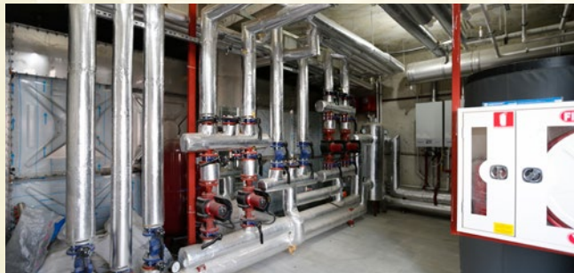
İstanbul Büyükçekmece'deki Güzelşehir İhlâs Câmii kazan dairesi ve su deposu ile yangın dolabı
