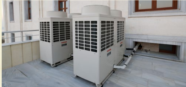
İstanbul Büyükçekmece'deki Güzelşehir İhlâs Câmii Klima sisteminin dış üniteleri
