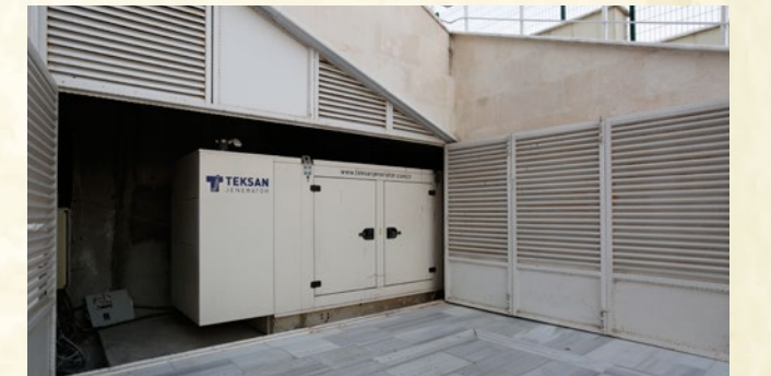
İstanbul Büyükçekmece'deki Güzelşehir İhlâs Câmîi'nin %100 beslemeli, 100 kVA'lık TEKSAN marka jeneratör sistemi.
